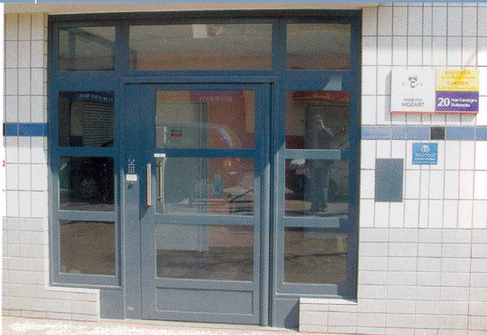
LES BLOCS-PORTES EN INOX THERMOLAQUÉ sont dotés d'un pivot anti-pince-doigts, d'un bouton de sortie antivandalisme à double commande (coupure de l'alimentation et commande temporisée par portier), d'une condamnation par deux ventouses magnétiques, chacune d'une force de rétention de 400 kg, et deux silentblochs d'amortissement de fermeture réglable. (Doc. OPHLM de Clichy-la-Garenne.)
